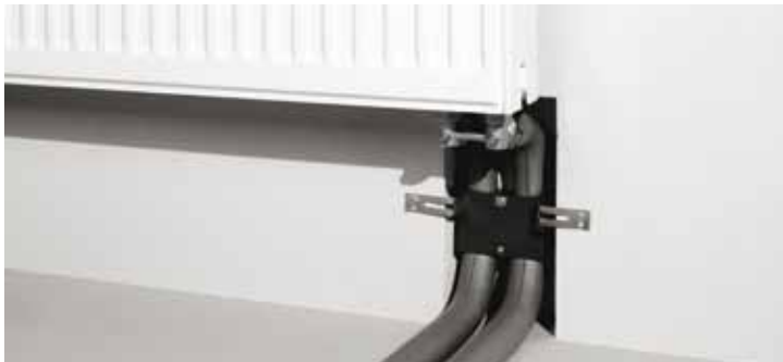
Подключение радиатора с использованием настенного монтажного узла
