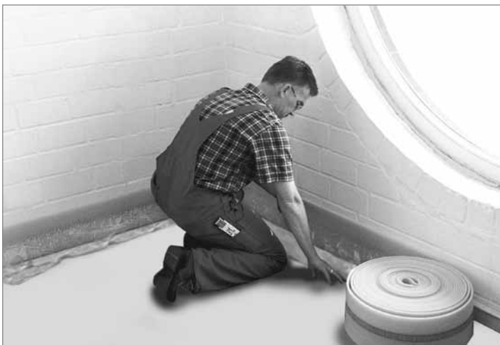
Укладка демпферной ленты
