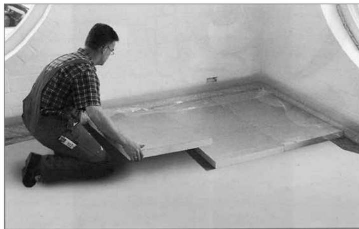
Укладка изоляции PUR
