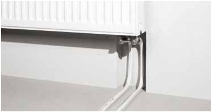
Подключение радиатора из стены
