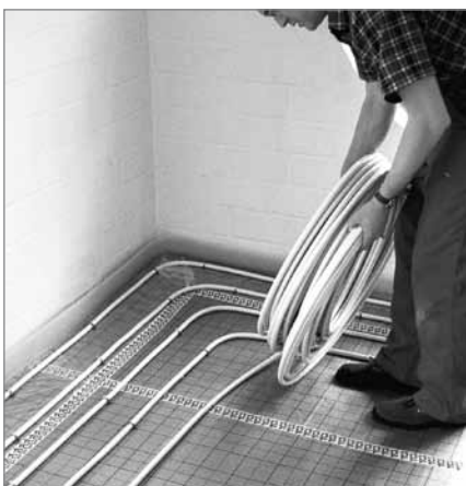
Укладка трубопровода
