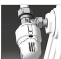
4. Выберите в соответствии со шкалой (см. упаковку) требуемое положение термоголовки и при необходимости зафиксируйте ползунком. Фиксация происходит при расположении ползунка строго напротив цифры. Установка требуемой комнатной температуры производится вращением терmostатической головки, имеющей градуированную шкалу для облегчения установки.
