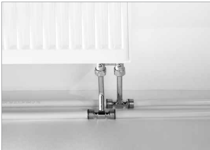
Подключение радиатора с использованием монтажных трубок
