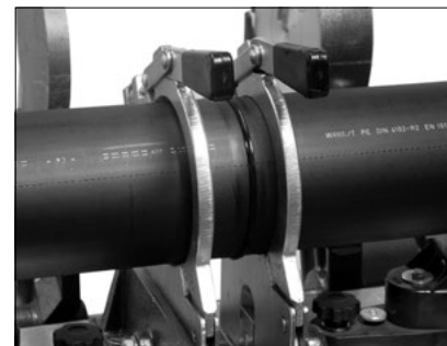
Охлаждение сварного шва
