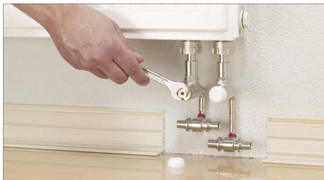
Рис. 18.11. Прочная затяжка резьбового соединения с обжимным фитингом
